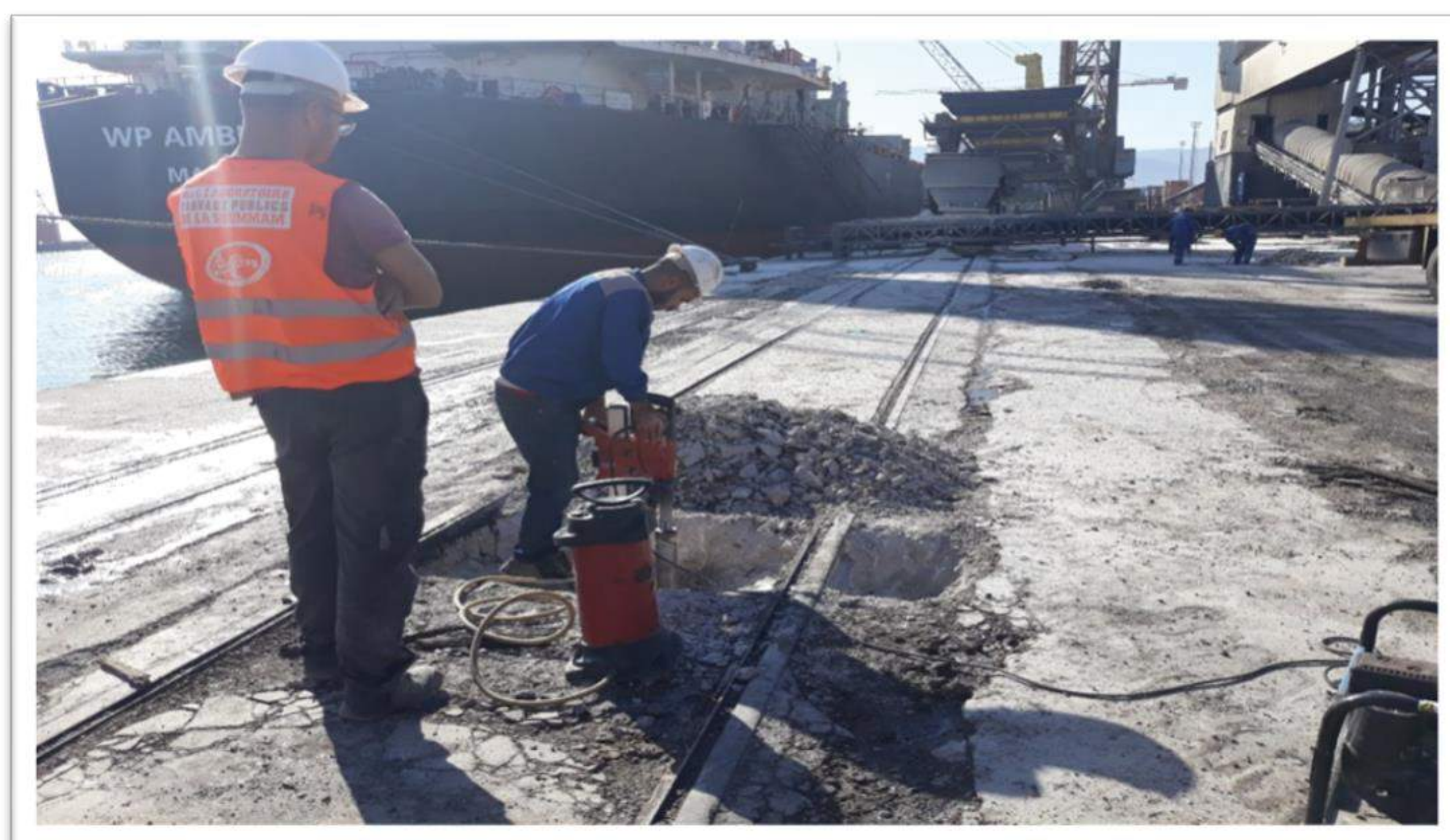
Opération de sondage
